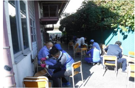
机・イスの補修（錆落とし・ヤスリがけ）
